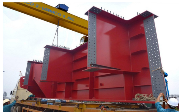
Gia công chế tạo & lắp kết cấu thép
