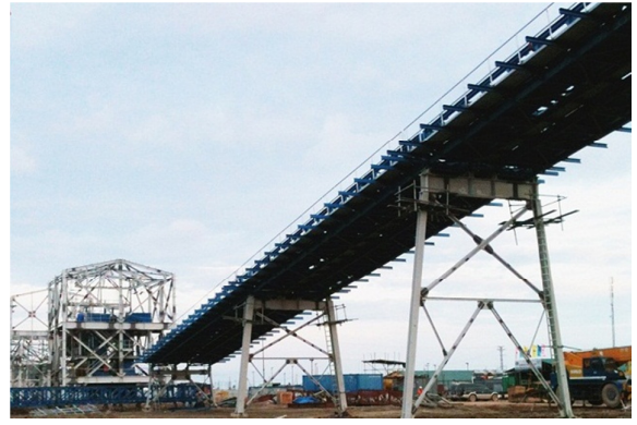
Gia công chế tạo và lắp hệ thống băng tải
