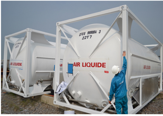
Gia công chế tạo và tổ hợp bình, bồn bể...
